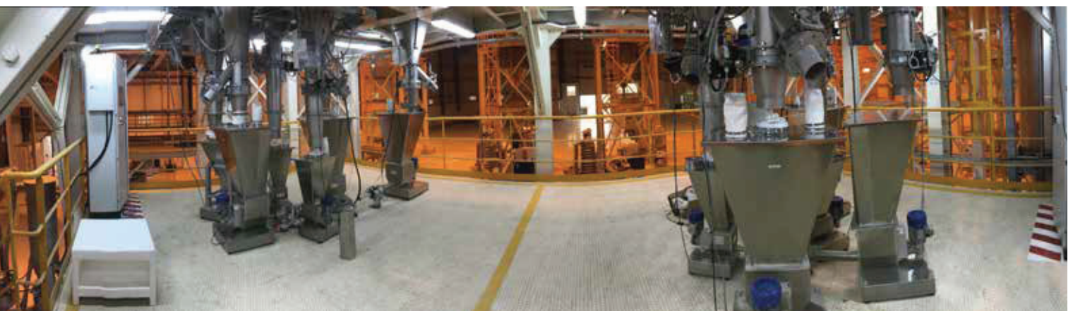
| Ligne d'extrusion et de dosage conçue par B2BPlast.
